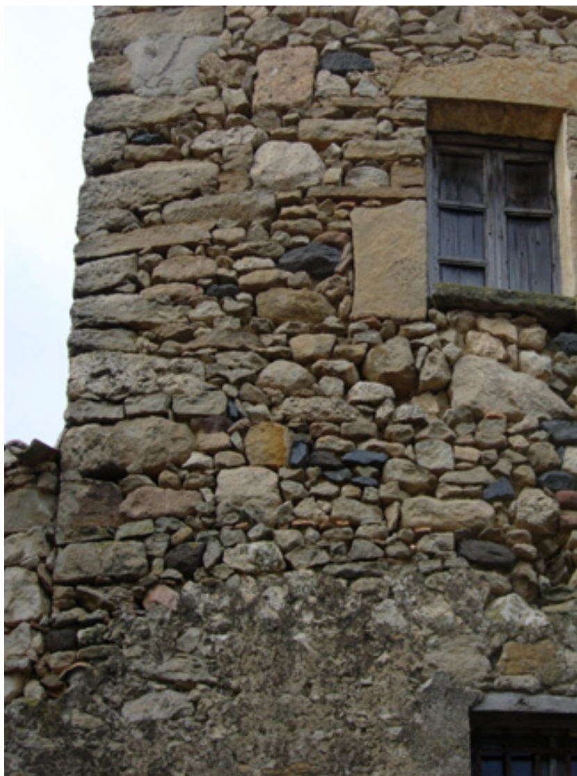
Fig. 1.64. Genoni. Soluzione d'angolo realizzata con blocchi sbazzati mentre nel resto della muratura vengono utilizzati trovanti di piccola pezzatura.
