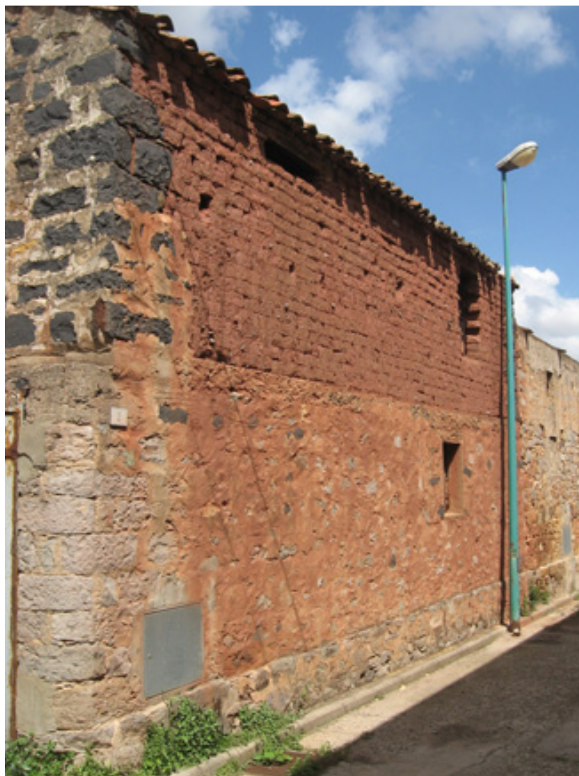
Fig. 1.65. Sarada. Sopraelevazione in ladiri su piano terra realizzato con trovanti di basalto, utilizzato anche per i cantonali del primo piano.
